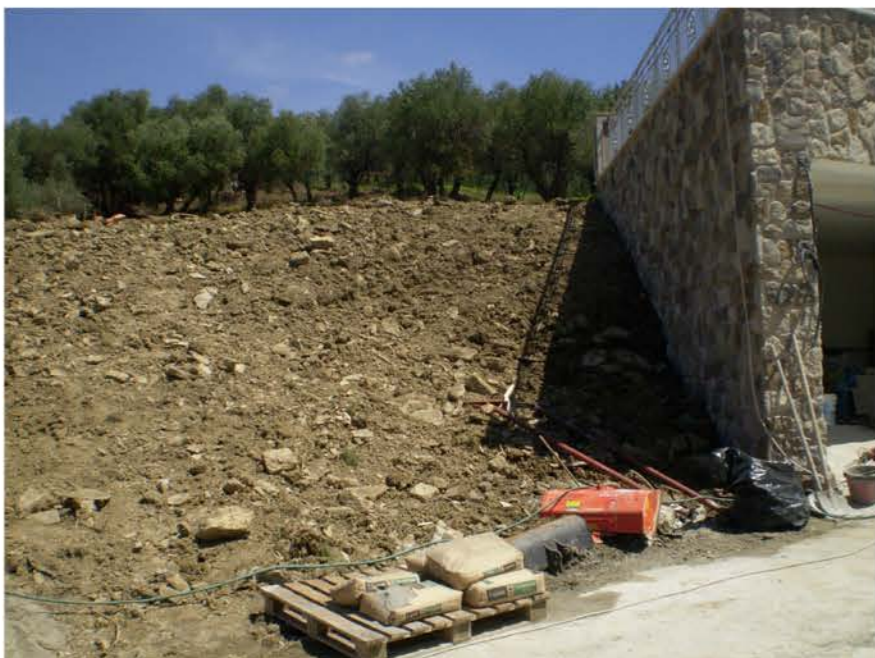
- scarpata di accesso alla piscina
